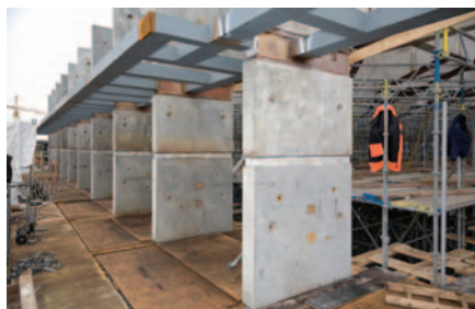
Geschweißte Fertigteile – Stützendetail
