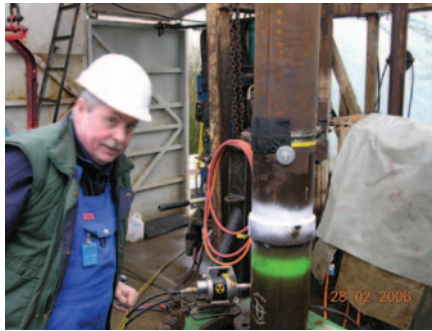
Durchstrahlungsprüfung an einer Förderrohrleitung mit IR 192
