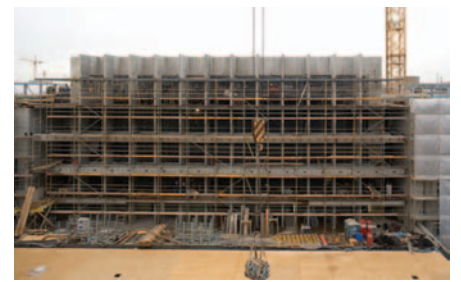
Rohbau des neuen Lesesaales der Staatsbibliothek
