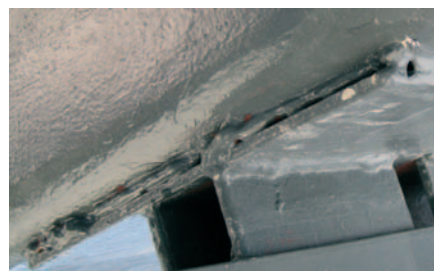
„Geschweißter“ Plattenanschluss an einen Träger
