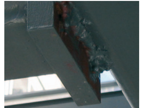
„Umschweißer“ biegesteifer Anschluss
